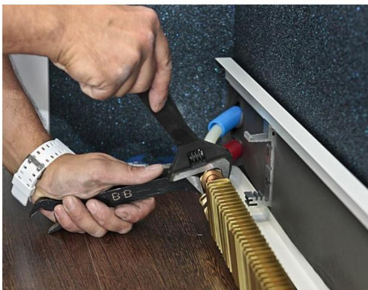
Рис. 24. Окончательный обжим. Осуществляется с усилием не менее, чем 55 – 60 н*м.
