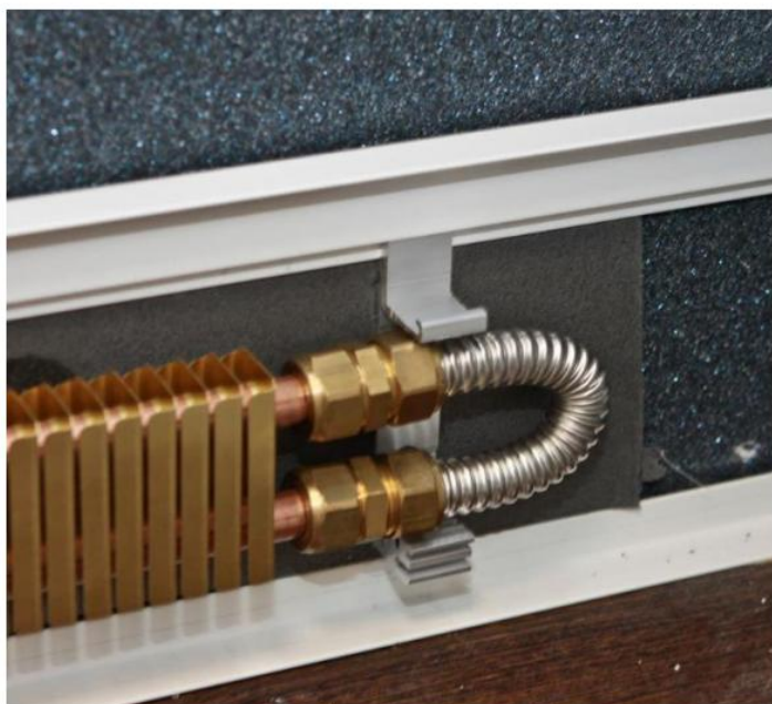
Рис. 29. Установка поворотного элемента в завершение контура. Обжим гаек на фитингах осуществляется с усилием не менее, чем 55 – 60 н*м.
