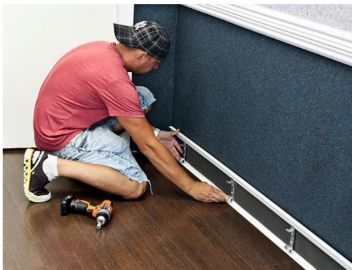
Рис. 15. Верхняя планка с кронштейнами устанавливается на подготовленное место к стене.
