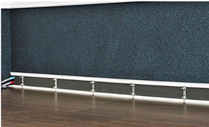
Рис. 18. Смонтированные линейные элементы – под установку греющего модуля.
