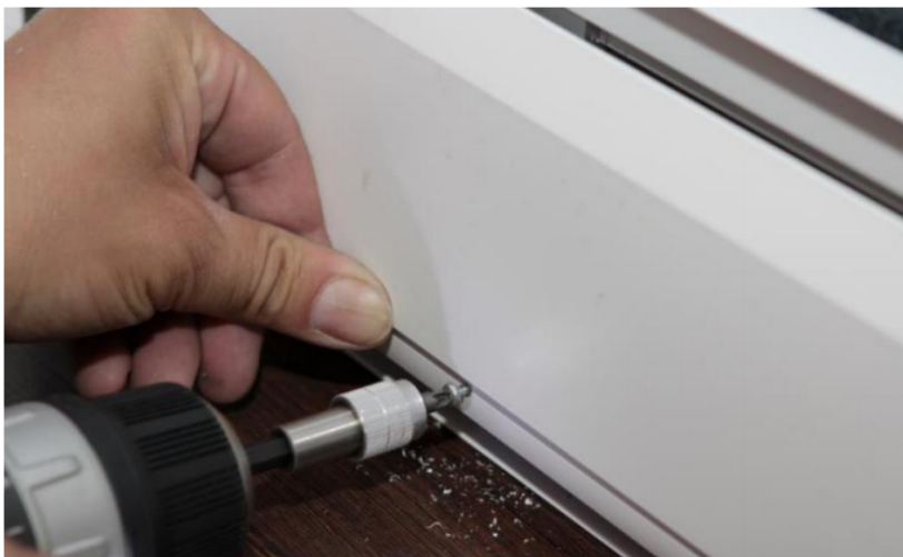
Рис. 34. Крепёж закрывающей планки.
