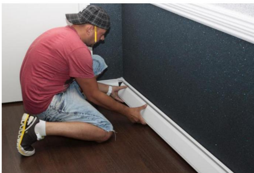
Рис. 33. Закрывающая планка крепится в зацепление к кронштейнам – необходимо вначале надеть верхнюю часть на крючки кронштейнов, а затем, с усилием, защелкнуть нижнюю часть.
