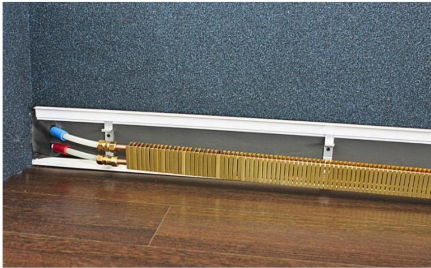
Рис. 25. Внешний вид соединения фитингами подводящих труб с трубками греющего модуля.
