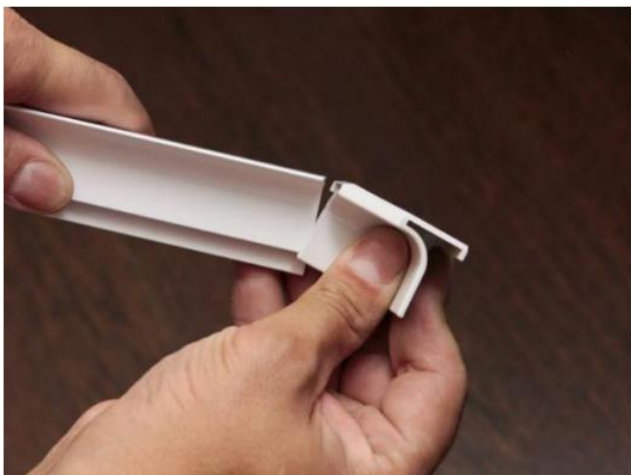
Рис. 37. Для установки угловых элементов верхние части уголков устанавливаются заранее, перед монтажом верхней планки с кронштейнами. Верхняя планка вставляется в декоративный элемент на глубину 10 – 15 мм.
