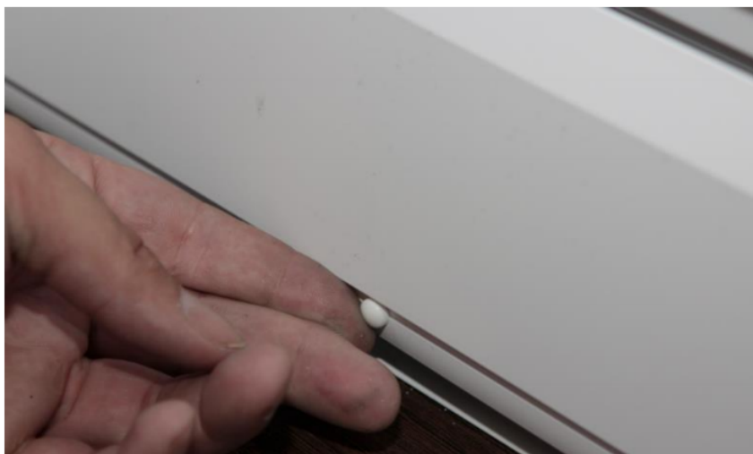
Рис. 35. Головки шурупов закрываются декоративными колпачками.
