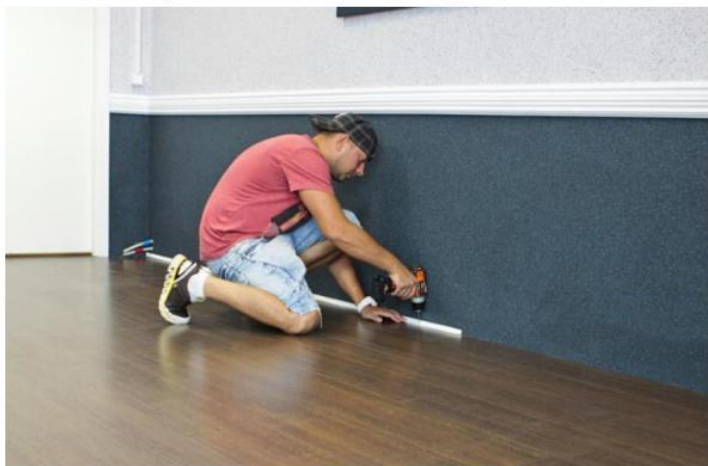
Рис. 5. Установка нижней планки на саморезы.
