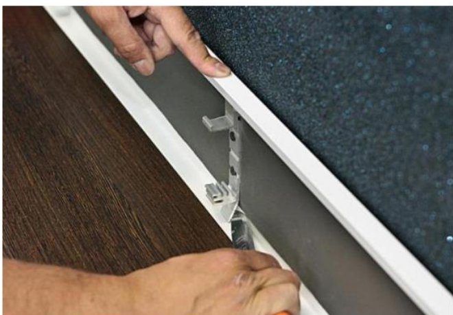
Рис. 19. Удаление нижней части кронштейнов – технологически они существуют только для точной (строго параллельной) установки верхней планки относительно нижней.
