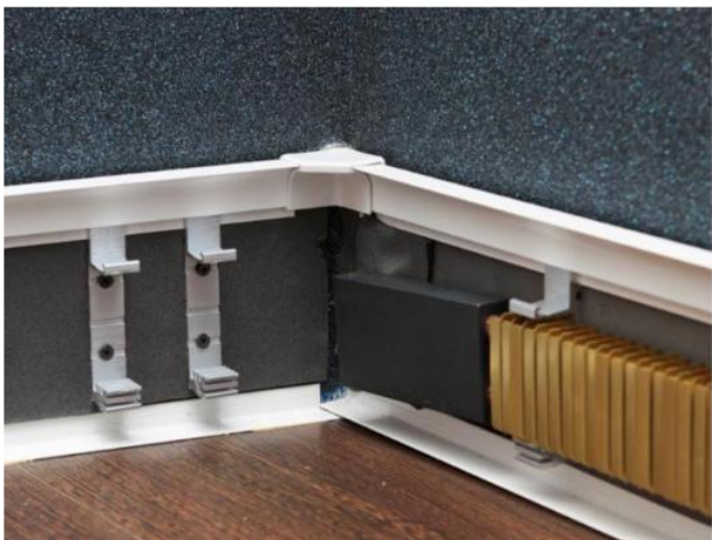
Рис. 38. Профиль теплого плинтуса, подготовленный под установку внутреннего угла.
