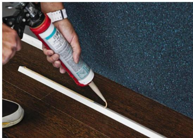
Рис. 6. Установка нижней планки на клей.
