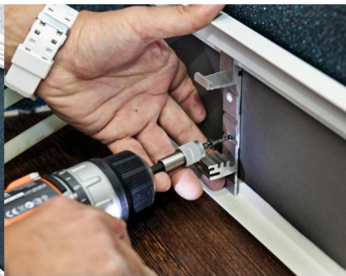
Рис. 16. Крепеж верхней планки с кронштейнами к стене.
