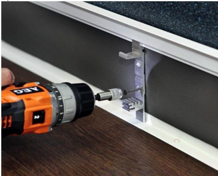
Рис. 17. Головки саморезов не должны торчать.
