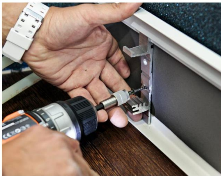
Рис. 16. Крепеж верхней планки с кронштейнами к
