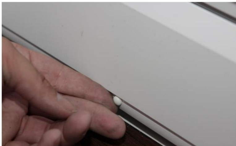
Рис. 36. Головки шурупов закрываются декоративными колпачками.
