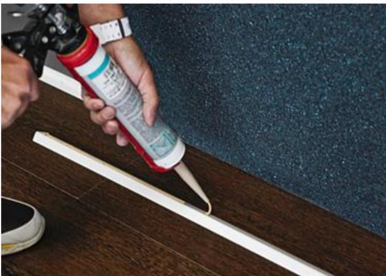
Рис. 6. Установка нижней планки на клей.
