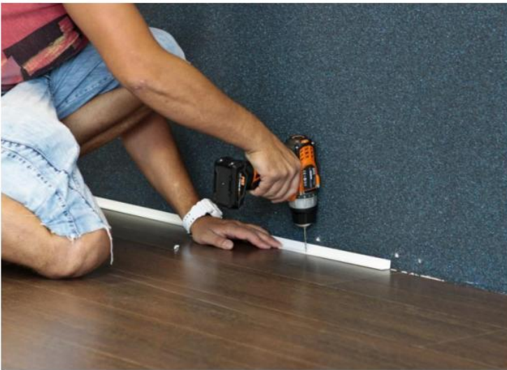
Рис. 5. Установка нижней планки на саморезы.
