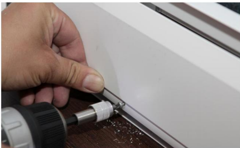
Рис. 35. Крепёж закрывающей планки.
