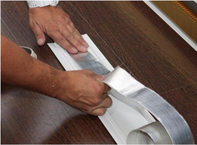
планки наклеивается теплоотражающая лента
